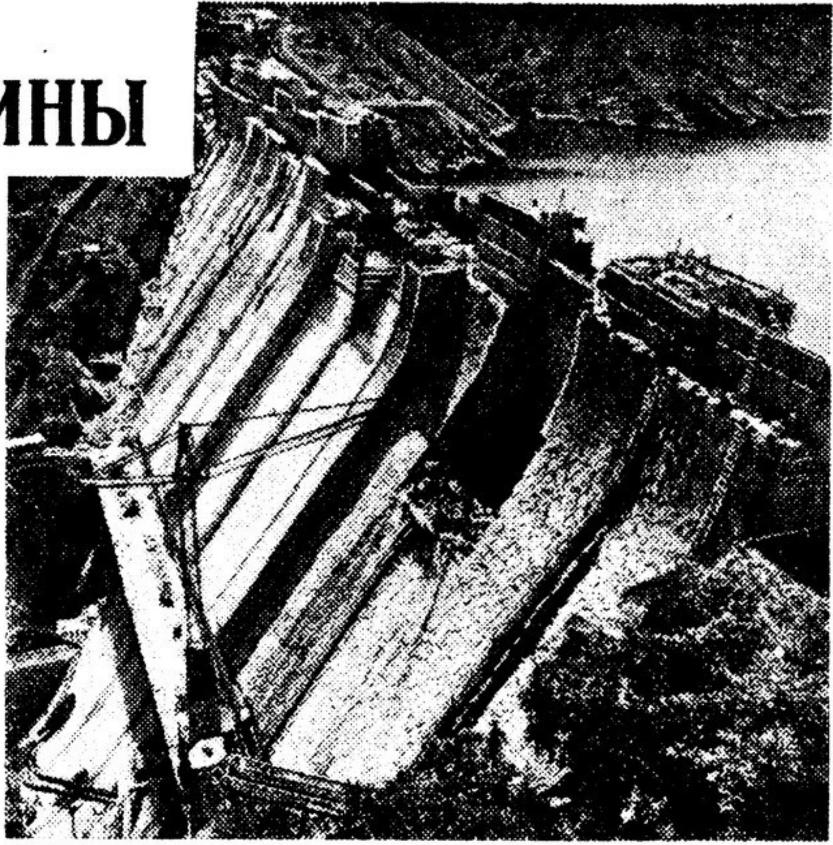
Плотина водохранилища имени Сталина около Софии.
